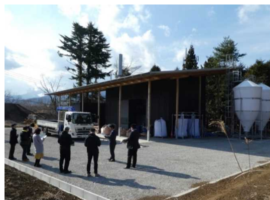
木質バイオマス発電所「森の金太郎発電所」(H30.9月発電開始)。100%間伐材等由来の木質ペレットを利用している。
